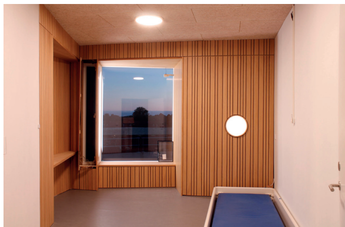
Niche i vinduet er optimeret, sådan at der kommer sollys ind i syd- og vestvendte sengestuer så tidligt som muligt. Samtidigt skaber nichen flere solskinstimer. Den drejbare 1:1 mockup repræsenterer en lille sengestue på 15 m 2 på Ny Psykiatri Bispebjerg. Foto: Carlo Volf
